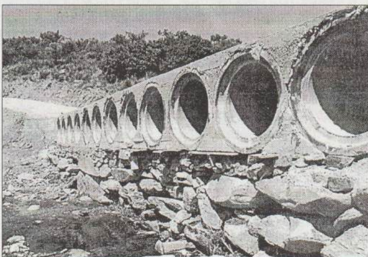
CONSTRUCCIÓN. Un lecho de granito con catorce tubos en hilera y una plancha de hormigón configuran el puente.
