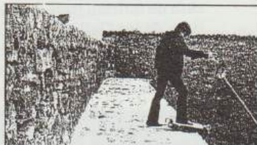
Se ha recuperado el antiguo grosor de la muralla.
