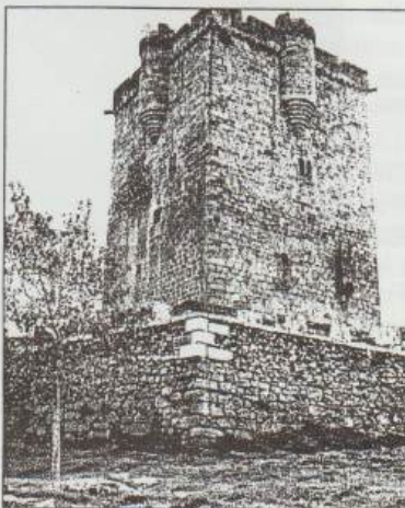
La muralla, ya restaurada.
