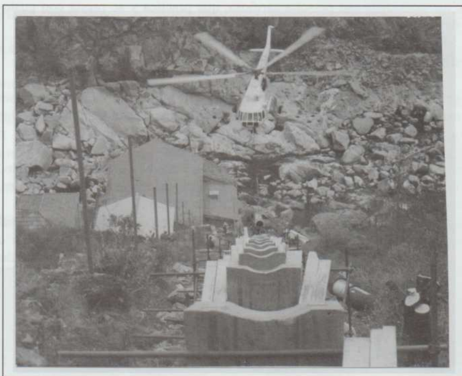
Instalación de los tubos de la central, en una bonita foto obtenida por D. José y que nos manda Epi.
