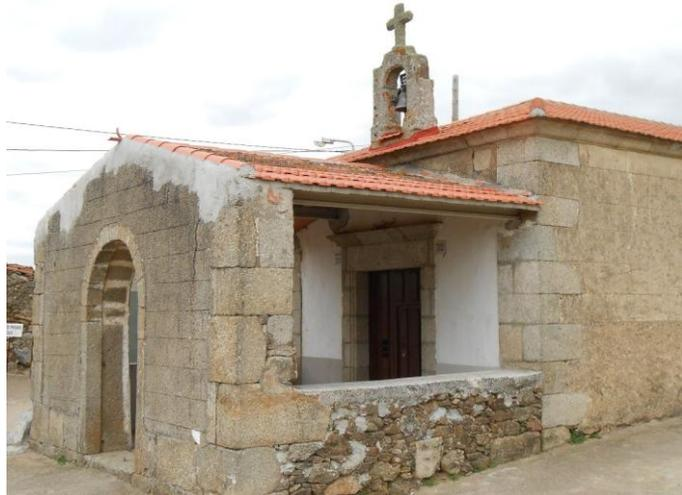
Estos días se está llevando a cabo una obra de adecuación de la sacristía repellando sus paredes y arreglando el tejado. También se ha picado el frontal de la puerta exterior y será cubierto con una capa de cemento.
